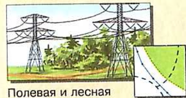
Полевая и лесная дороги. Линия электропередачи
